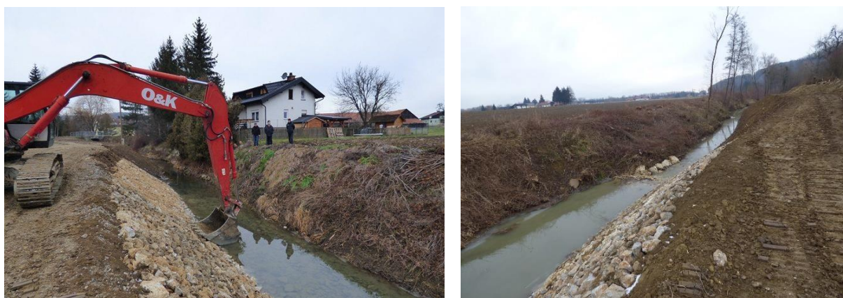
Slika 3. Uređenje dijela vodotoka Zajza tijekom 2019
