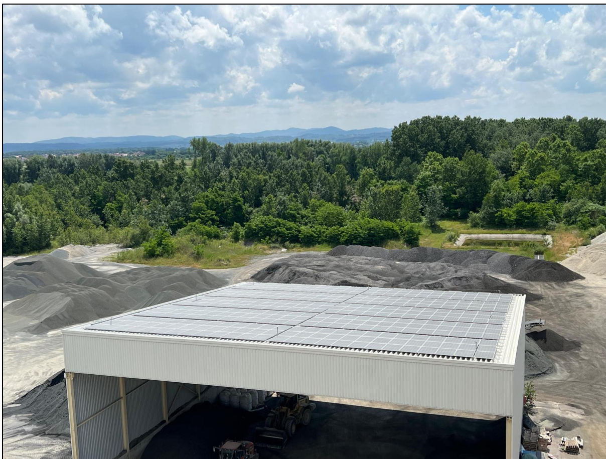
Slika 1. Sunčana elektrana koja se nalazi na postojećoj nadstrešnici predmetne lokacije
