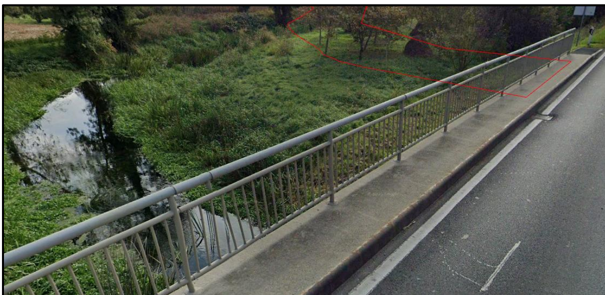
Slika 2.1-12. Pogled nizvodno na rijeku Plitvicu snimljen sa cestovnog mosta državne ceste DC2 (cestovni most Vrbanovec-Zamlaka), stac. km 23+554, s označenim položajem zahvatom planiranog nasipa
