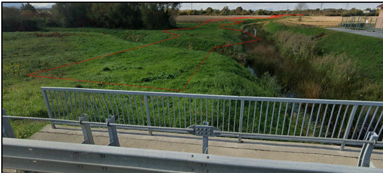
Slika 2.1-1. Pogled uzvodno na rijeku Plitvicu snimljen sa cestovnog mosta državne ceste DC 4 (Varaždin – istočna obilaznica), stac. km 37+964, s označenim položajem zahvatom planiranog nasipa
