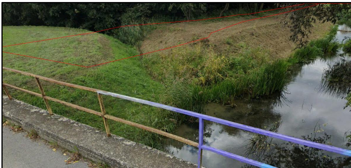
Slika 2.1-5. Pogled uzvodno na rijeku Plitvicu snimljen sa cestovnog mosta nerazvrstane ceste Staromlinska ulica (cestovni most Kučan Gornji), stac. km 34+615, s označenim položajem zahvatom planiranog nasipa
