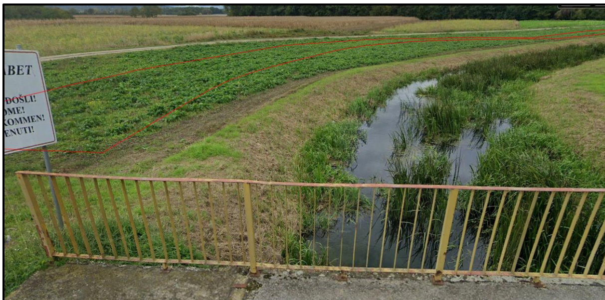
Slika 2.1-9. Pogled uzvodno na rijeku Plitvicu snimljen sa cestovnog mosta županijske ceste ŽC2054 7 (Plitvička ulica; cestovni most Jalžabet-Šemovec), stac. km 28+140, s označenim položajem zahvatom planiranog nasipa
