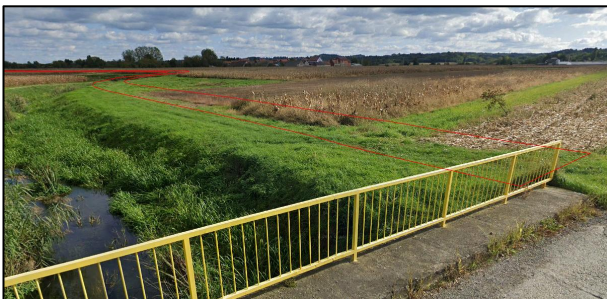
Slika 2.1-10. Pogled nizvodno na rijeku Plitvicu snimljen sa cestovnog mosta lokalne ceste LC25084 (Novakovečka ulica; cestovni most Novakovec-Zamlaka), stac. km 26+366, s označenim položajem zahvatom planiranog nasipa
