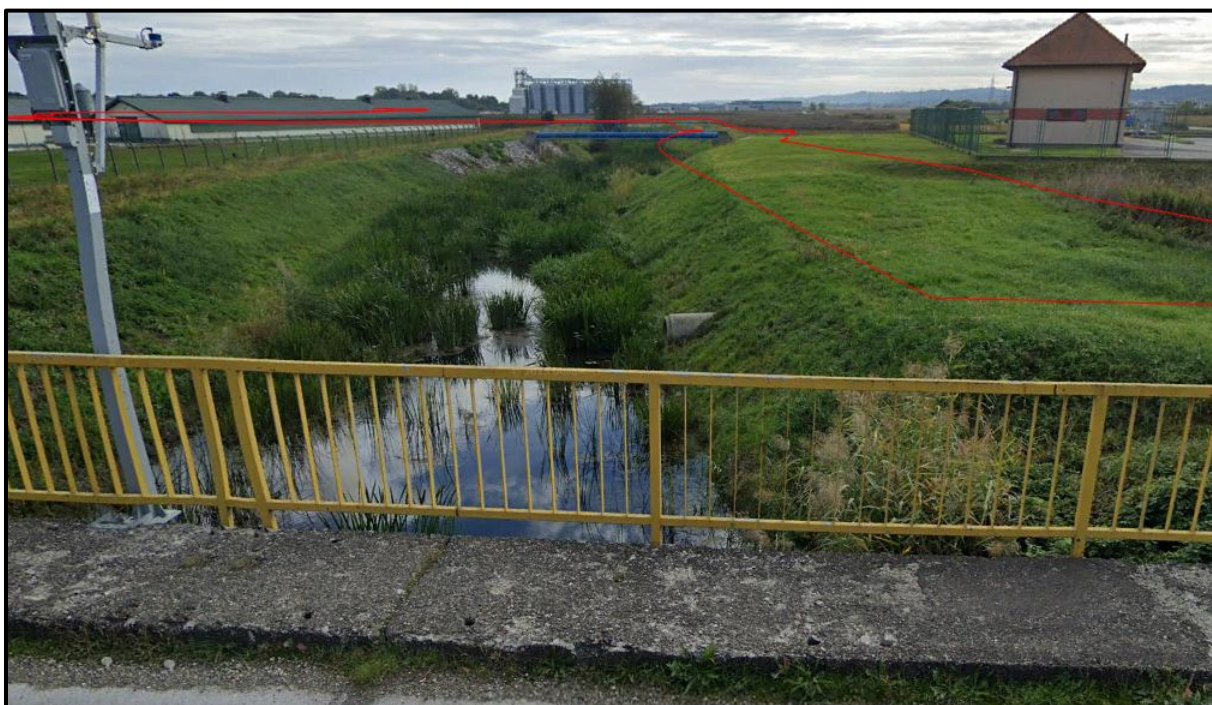
Slika 2.1-4. Pogled nizvodno na rijeku Plitvicu snimljen sa cestovnog mosta županijske ceste ŽC2070 (Kučanska ulica; cestovni most KneGINEC Donji - Kučan Gornji), stac. km 36+365, s označenim položajem zahvatom planiranog nasipa
