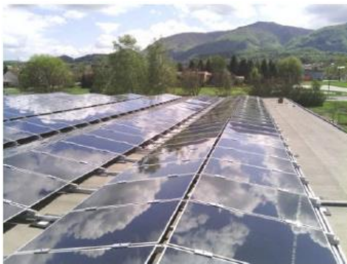
Slika 5. Način postavljanja modula na ravni krov
